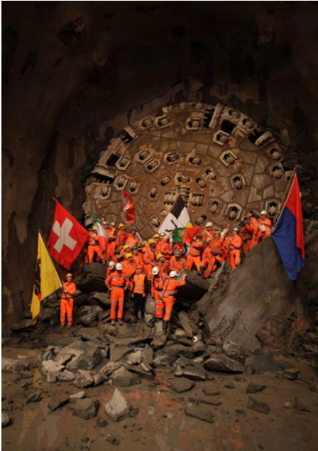
Túnel San Gotardo. © AlpTransit Gotthard AG
