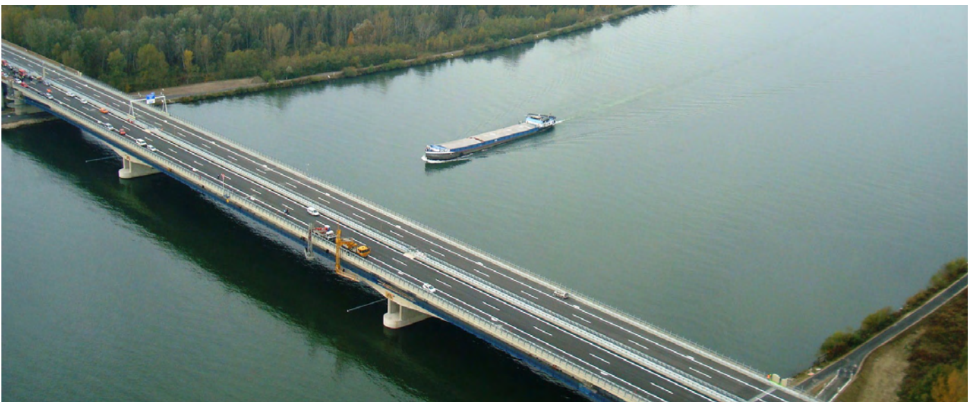
Puente de Traismauer
